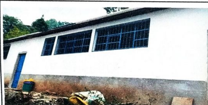
Colocacion de Balcones y ventanas.
