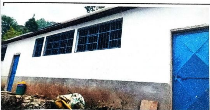
Sustitucion de puertas de madera a metal.
