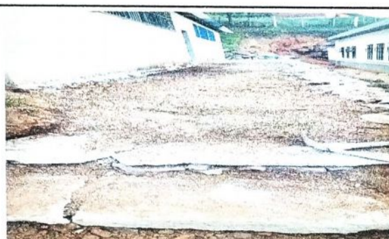
Reparacion de concreto de patio.
