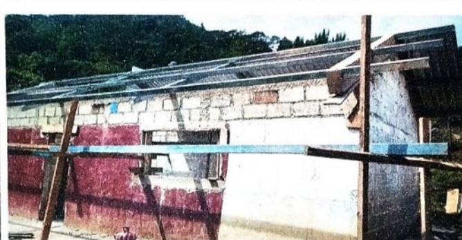
Aula No. 1: Cambio de techos: láminas troquelados, y de costaneras.
