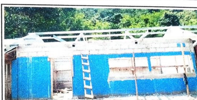
Aula No 2: Cambio de techo de lamina troquelada, costanera, puertas y ventanas.
