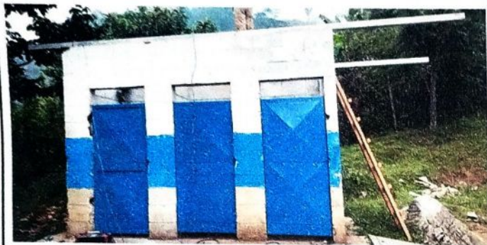
Baño: cambio de 3 puertas: Medidas. Ancho 83cm, largo 1.47cm, cambio costaneras.
